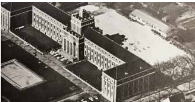
Schulgebäude mit Pavillon und zerstörtem Wasserbecken nach 1962
