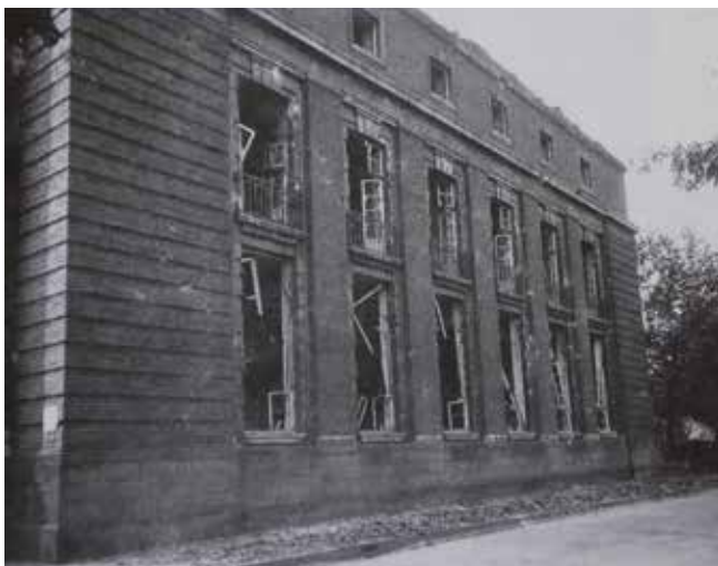
Zerstörung an Festsaal (heutige Aula) und Sporthalle 1942
